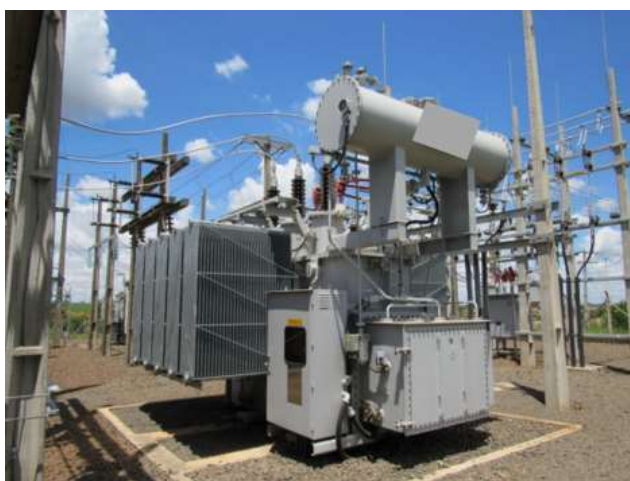
Figura 1: Transformador retirado de operação ainda na Subestação.
