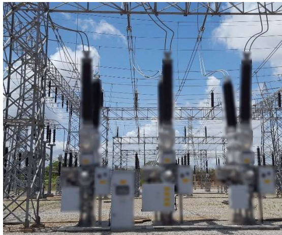
Figura 2 – Tecnologia de Módulos Híbridos Compactos aplicada a seccionamento de barras
