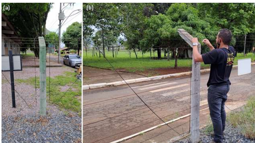
FIGURA 7 – Instalação do cabo óptico na cerca. (a) loop ao redor de um dos mourões de concreto e (b) fixação do cabo de fibra óptica à cerca.
