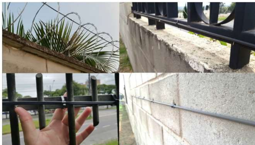
FIGURA 4 – Diferentes instalações do cabo sensor em cercas e muros.
