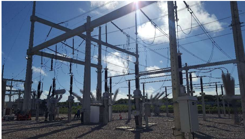
Figura 1 – Subestação projetada com a tecnologia de módulos híbridos compactos
