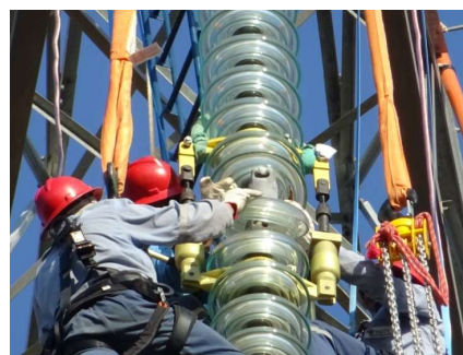
FIGURA 8 – Aplicação de dispositivo para troca pontual de isolador quebrado
