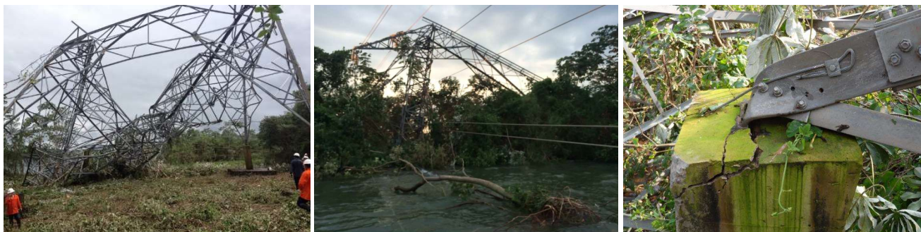
Figura 4 – Colapso da torre T10 (4/1).
