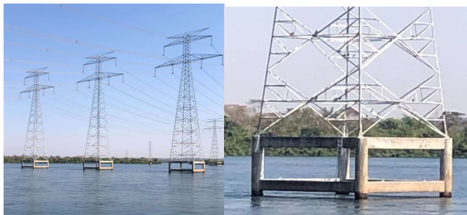
FIGURA 4 –Fundação existente no local (LT próxima).
