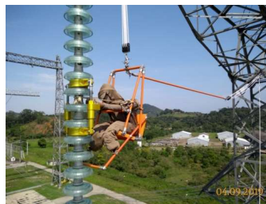
FIGURA 13 – Simulação da troca de isolador no meio da cadeia usando dispositivo de troca
