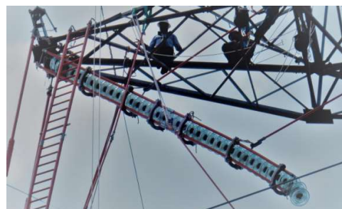
FIGURA 6 – Procedimento de troca de isolador quebrado usando o berço
