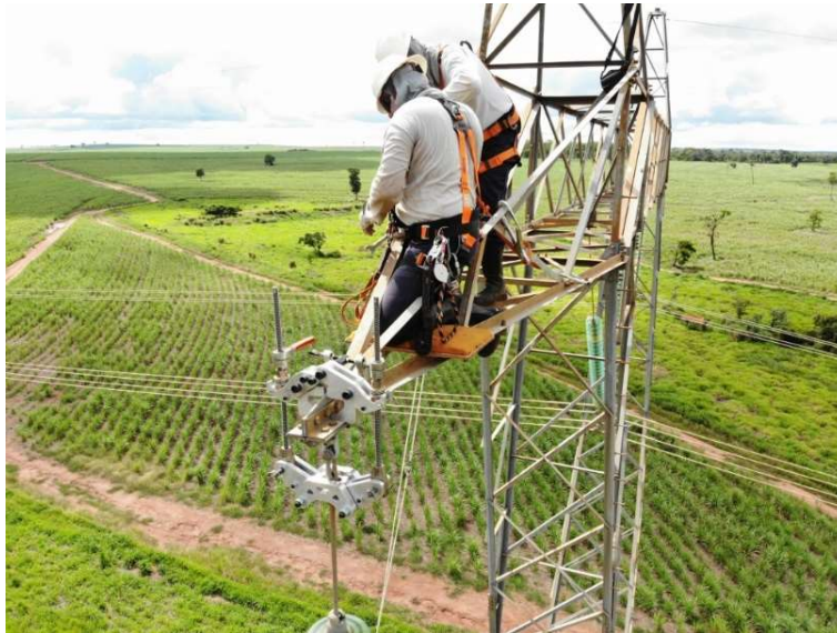
FIGURA 1: Posição do munhão sobre a extremidade da mísula (CTEEP, 2019).
