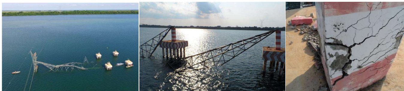
Figura 3 – Colapso da torre T09 (3/2).
