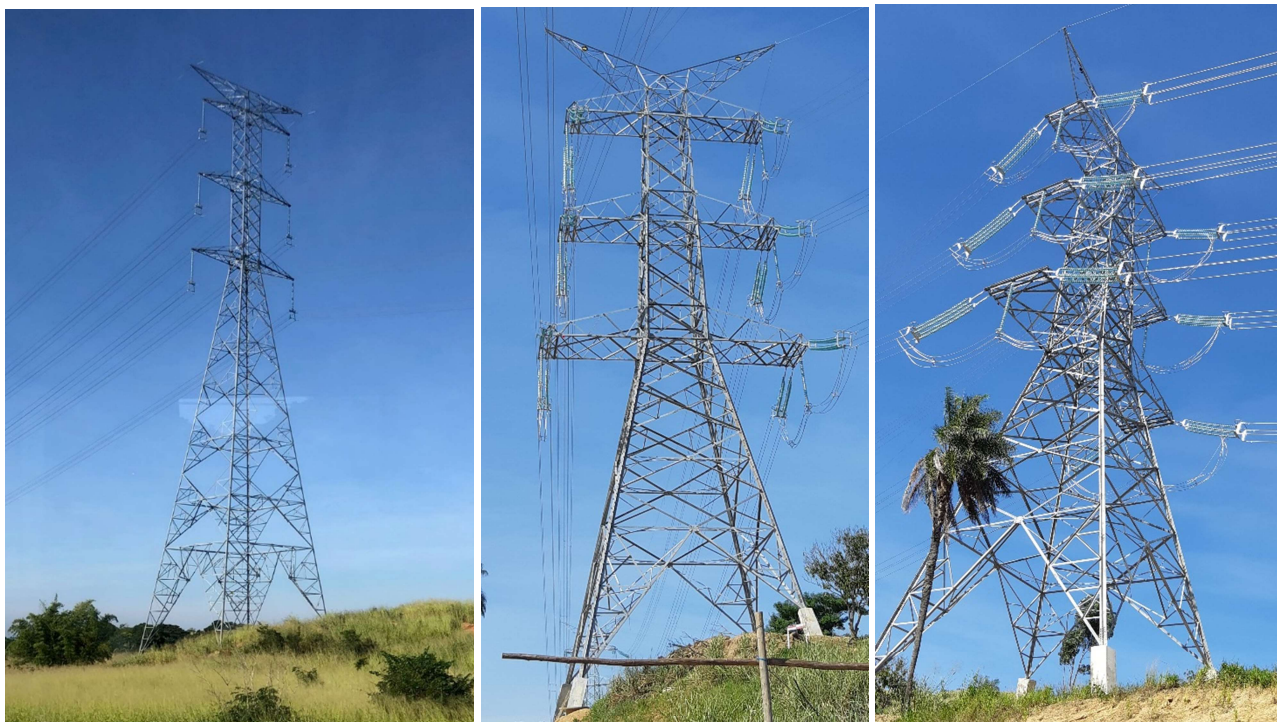
Figura 7 – Estruturas de suspensão e ancoragem da LT 500kV TRIO – NVI.
