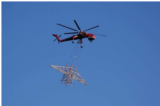
Figura 1 – Helicóptero transportando um módulo de uma estrutura – Longwood Lake Cabin Owners Association (4)
