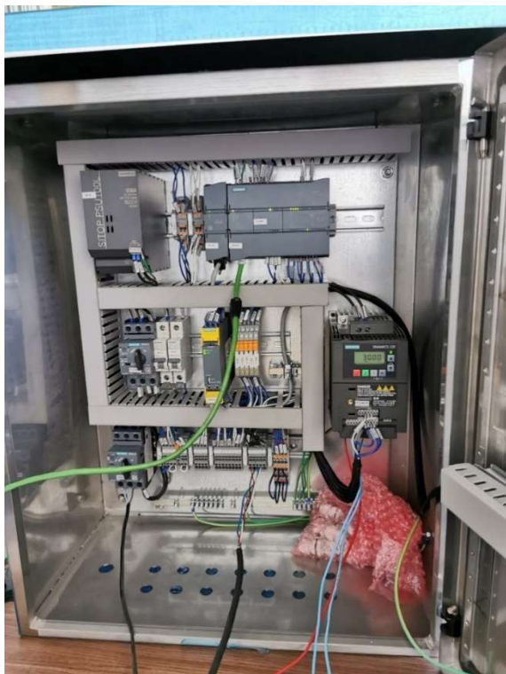
Figura 7 – Foto interna do quadro de automação e controle do tracker
