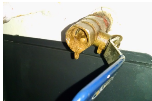
Figura 3 – (d) – Massa similar à borra no tanque de armazenamento temporário T2
