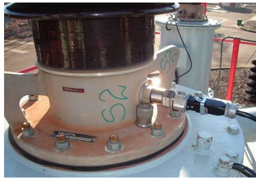
Figura 4– Conexão direta do sistema de monitoração ao tap de bucha do lado [5]
