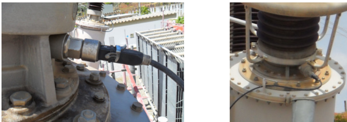
Figura 2 - Exemplo de instalação de adaptadores de tap. Fonte: [7].
