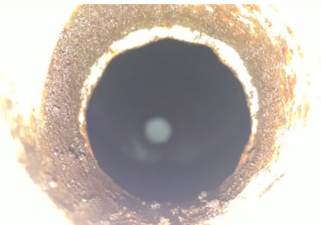
Figura 3 – (c) – Parede interna do tanque de armazenamento temporário T2
