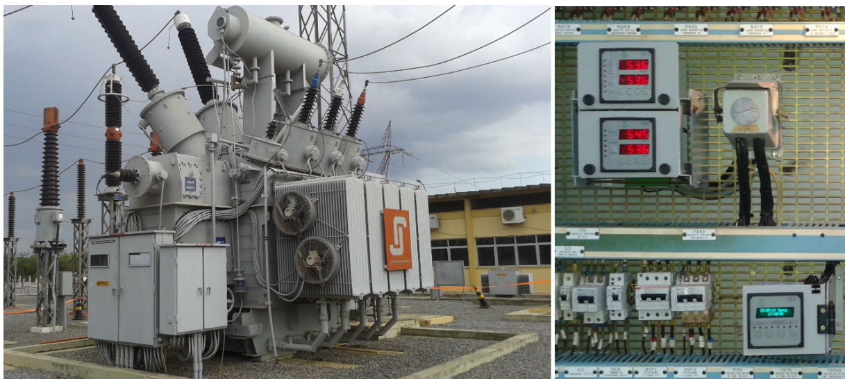
Figura 5 – Transformador em SE Nova Mutum e DEIs instalados no interior do painel
