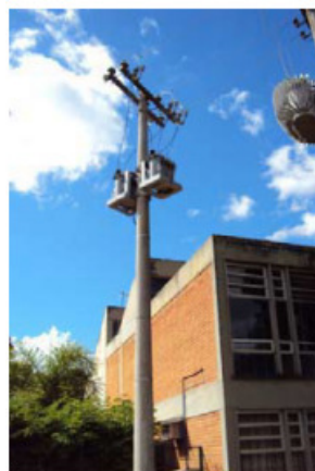
FIGURA 6 – Transformadores instalados
