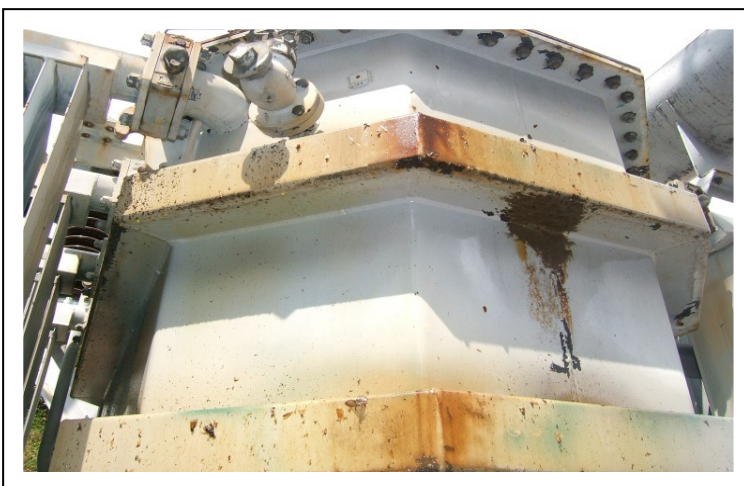
FIGURA 4 – Transformadores substituídos, em final de vida
