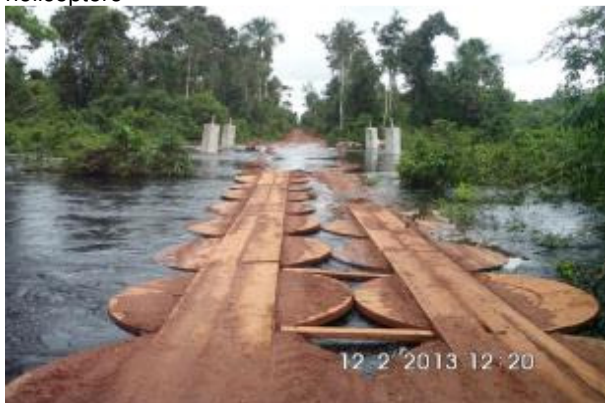
Figura 6 – Construção de acessos com tampas de bobinas em áreas alagadas
