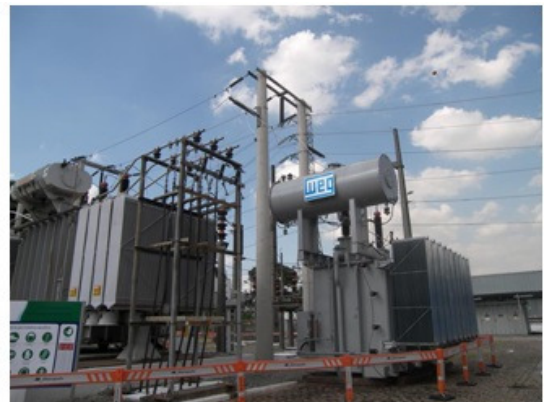
b) Transformador reserva em barramento
