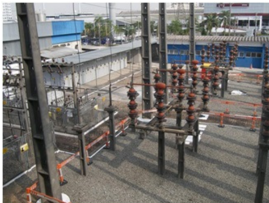
a) Chaves seccionadoras a serem substituídas temporário
