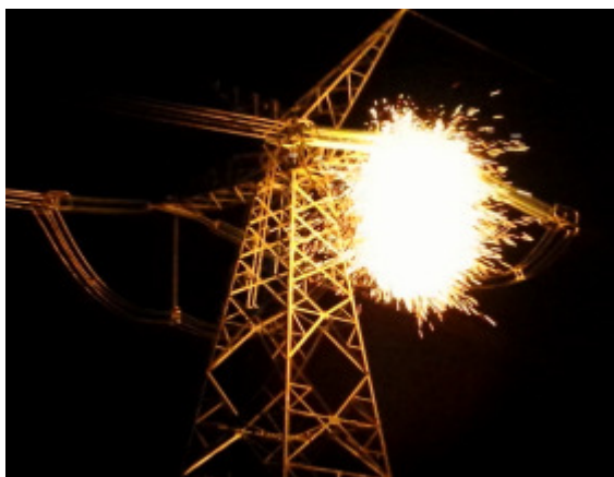
Figura 12 – Foto do curto circuito
