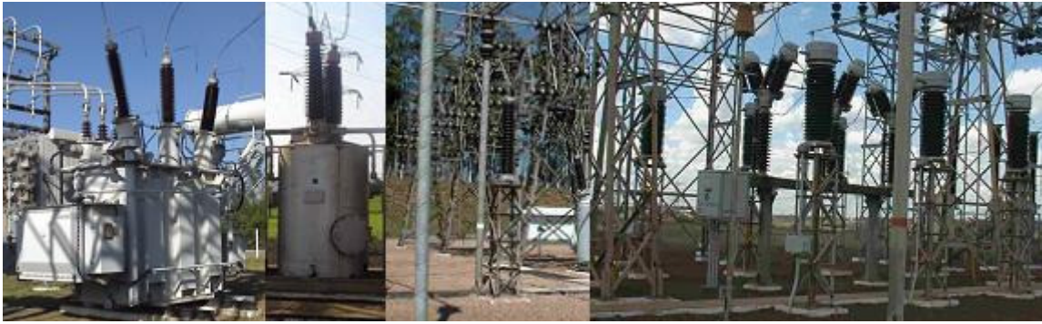
FIGURA 4 – Transformadores de Potência – Disjuntores GVO – Para Raios SiC – Transformadores de Instrumentos
