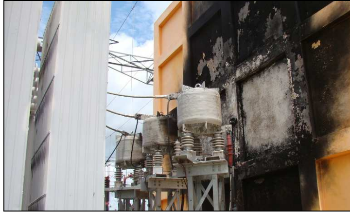
FIGURA 4 – Foto dos reatores limitadores avariados após curto-circuito
