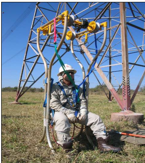
FIGURA 3 - Detalhe da fita de segurança fixada no eletricitista, envolvendo toda a cadeira
