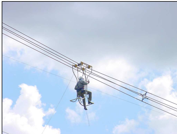
FIGURA 2 – Eletricitista na cadeira se aproximando do espaçador para teste de transposição
