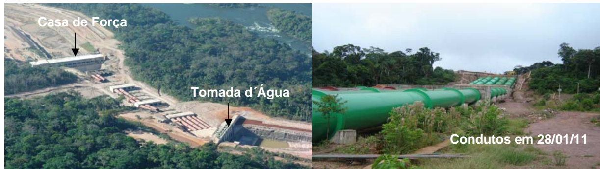
FIGURA 2 – A esquerda fase de montagem dos condutos forçados, a direita condutos montados e pintados
