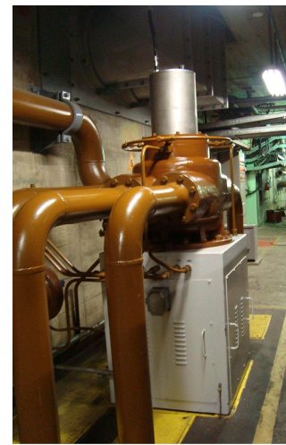
FIGURA 4 – Válvula Distribuidora Modernizada pela ALSTOM em 4 etapas: existente, projeto, ensaio, final
