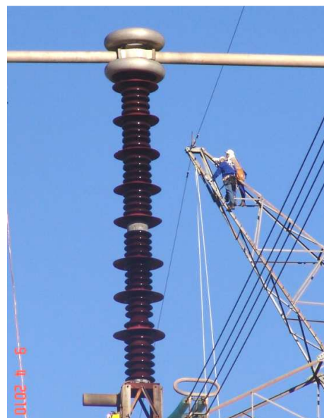
Figura 6 – Coluna de Isoladores com Booster Sheds
