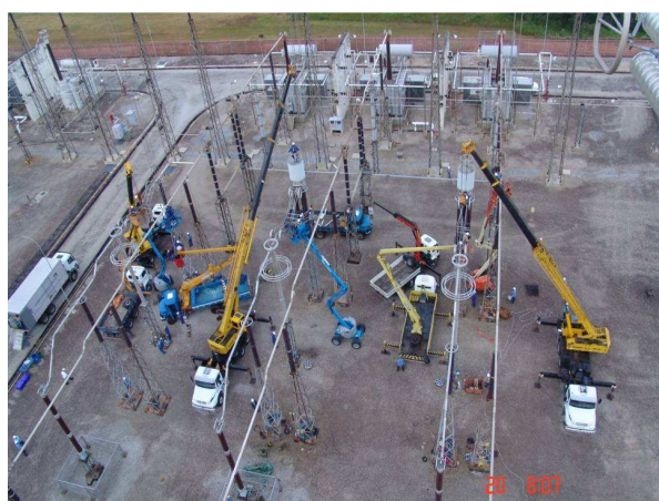
Figura 7 – Retirada dos Filtros de Onda
