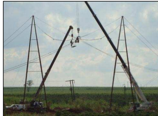
FIGURA 12 - içamento dos feixes de cabos
