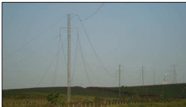
FIGURA 13 - Vista da variante do circuito 2 durante o lançamento de cabos
