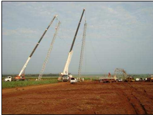
FIGURA 9 - Vista do içamento de dois mastros interligados pela chainete
