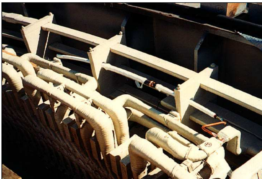
Figura 1: Foto de um sensor tipo cabo de 80 pF (em processo de instalação) que foi amplamente utilizado na década de 1980 para detectar o PD em hidrogeradores.
