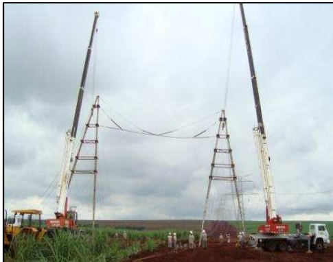
FIGURA 11 - içamento das duas estruturas Delta interligadas pela chainete compacta
