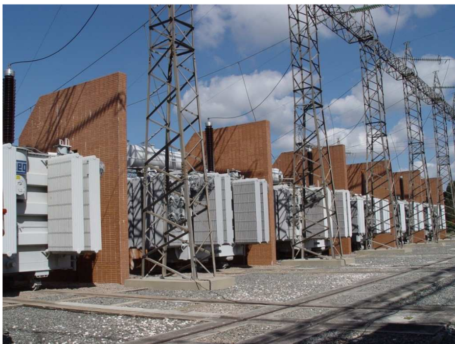
FIGURA 2 – Banco de Transformadores
