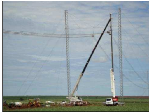
FIGURA 10 - Vista do içamento dos feixes de cabos
