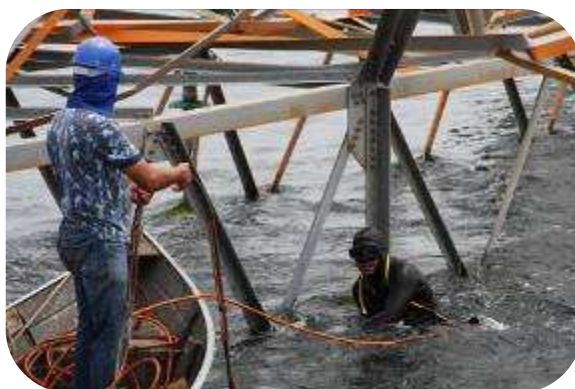
FIGURA 8 – Corte de peças submersas por mergulhador.
