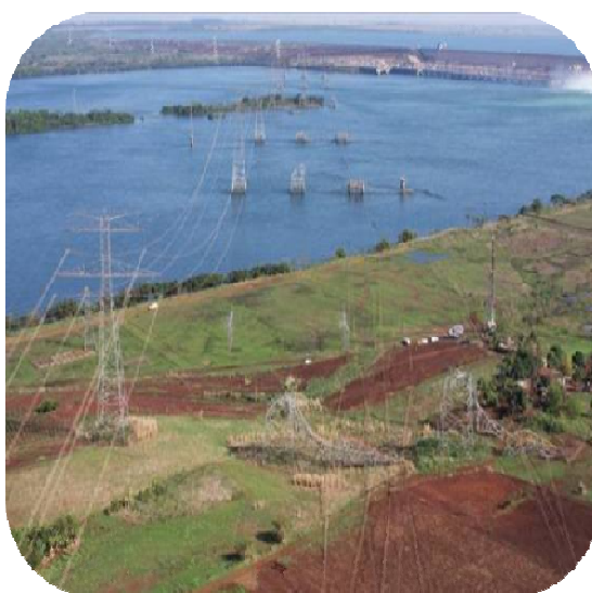
FIGURA 2 – Vista das estruturas em ruína na jusante da Usina de Ilha Solteira.
