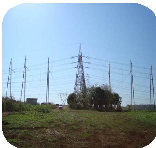
FIGURA 4 – Vista das estruturas de emergência utilizadas na montagem do barramento provisório.
