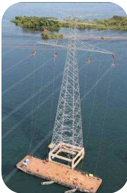
FIGURA 7 – Vista do lançamento dos cabos condutores e para-raios com apoio da balsa.
