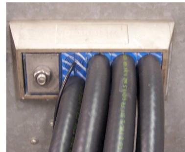
Figura 7 – Sistema de passagem de cabos da ROXTEC
