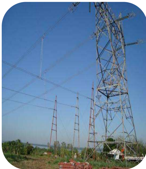
FIGURA 5 – Vista das estruturas de emergência utilizadas como ancoragem nas extremidades do barramento.
