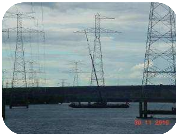
FIGURA 6 – Vista da montagem de estrutura com guindaste embarcado em balsa.
