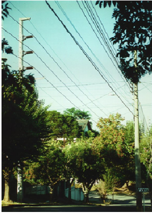
FIGURA 1 – LT Urbana circuito simples padrão Copel. Fonte – Arquivo Copel Transmissão.
