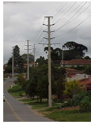
FIGURA 2 – LT urbana circuito duplo padrão Copel. Fonte – Arquivo Copel Transmissão.
