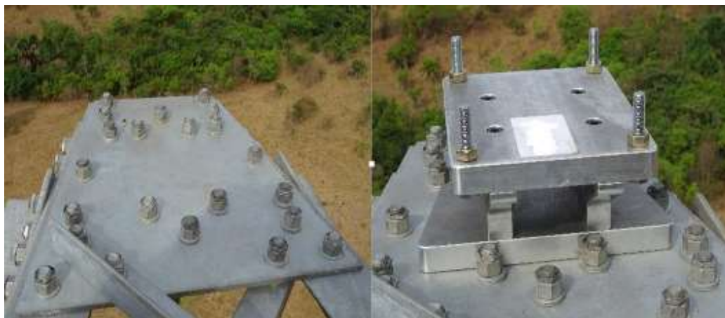
Figura 8 - Detalhe da ponta da mísula e adaptador para instalação de jugo – Verificação de montagem
