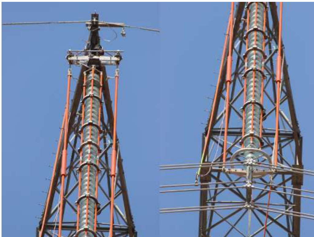
Figura 9 - Instalação das ferramentas no bipolo 2 em regime desenergizado
