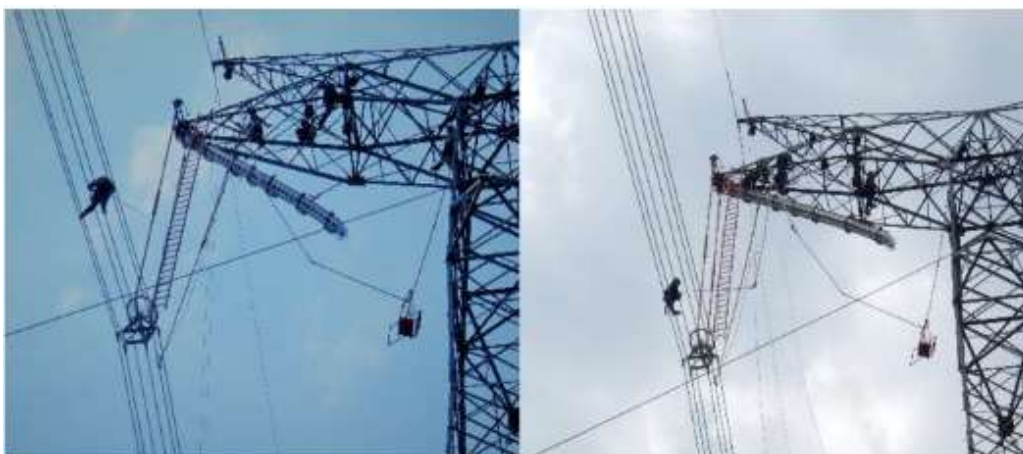
Figura 10 - Içamento e posicionamento da cadeia de isoladores na mísula
