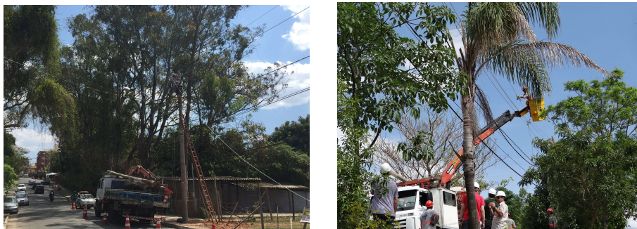
FIGURAS 5 e 6 – Circuitos selecionados para o projeto piloto instalando o cabo coberto dupla camada
